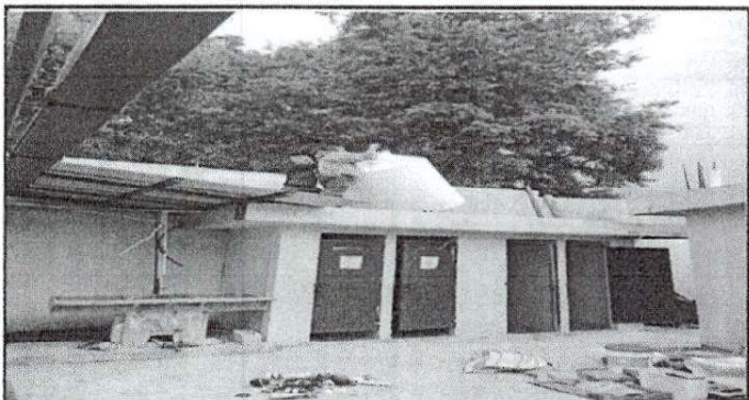
Foto 3: Sustitución de la tubería de agua potable
